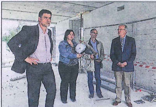
Visite du chantier pour les services et élus du conseil départemental.
