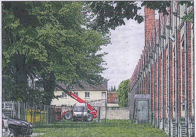
Les travaux ont débuté derrière les bâtiments actuels du Coq sportif.
