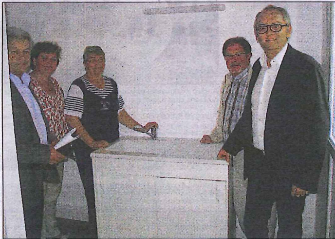
Mardi, les élus et les membres du CCAS ont visité le chantier, guidés par la directrice et les représentants du cabinet d'architecte
